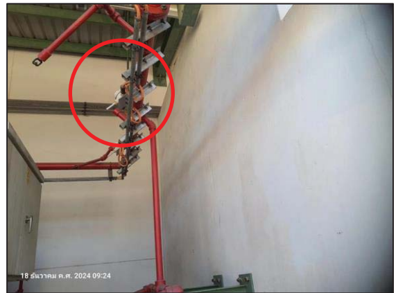
รูปที่ 3.32 Heat Detector
