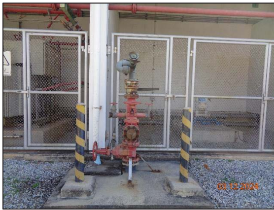
รูปที่ 3.37 Fire Hydrant
