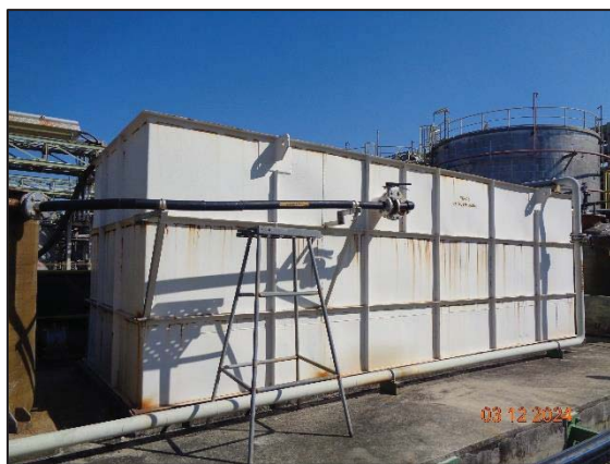
รูปที่ 3.15 Oil-water Separator (CPI)
