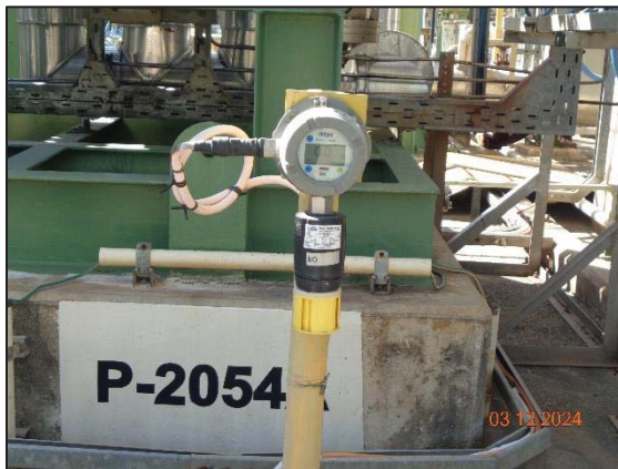
รูปที่ 3.31 EO Analyzer
