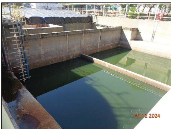
รูปที่ 3.17 Emergency Wastewater Basin
