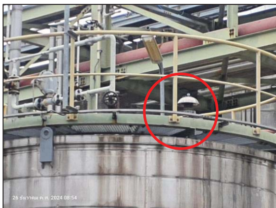
รูปที่ 3.47 Pressure Safety Valve
