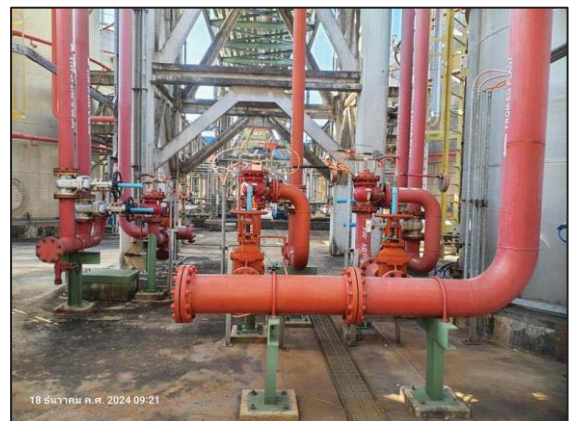
รูปที่ 3.41 Hydrant with Monitor
