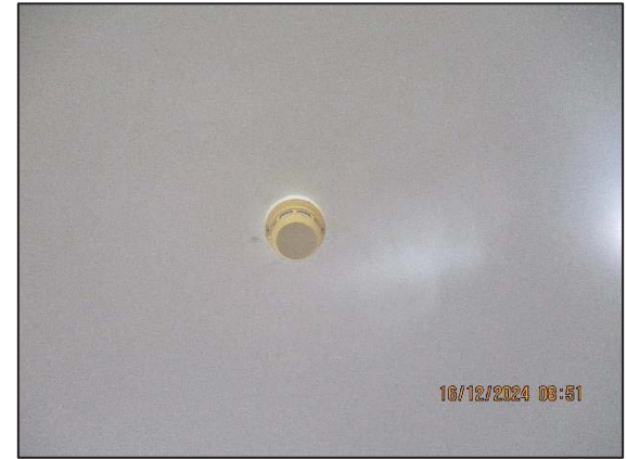
รูปที่ 3.34 Smoke Detector
