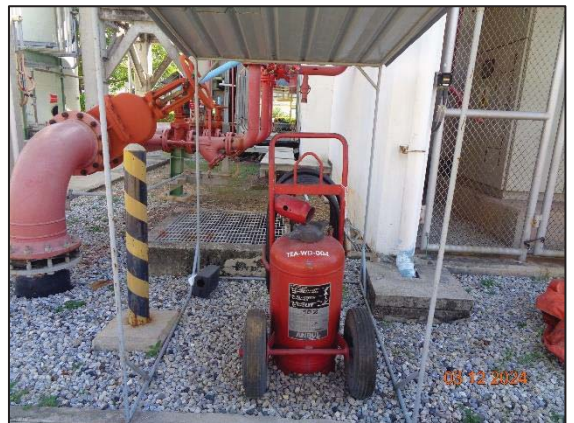
รูปที่ 3.39 ถัง Wheel Dry Chemical
