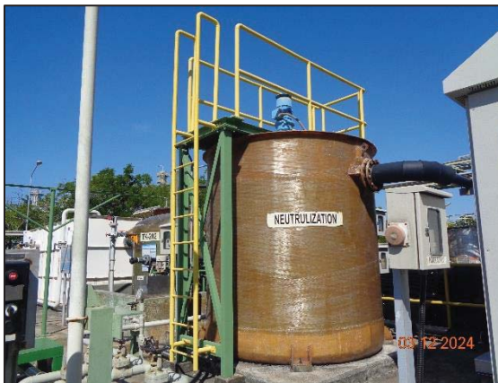
รูปที่ 3.3 บ่อ Neutralization (TK 201)
