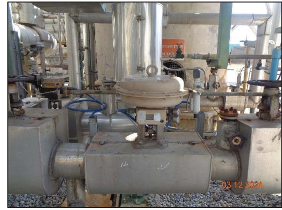
รูปที่ 3.4 Flow Controller
