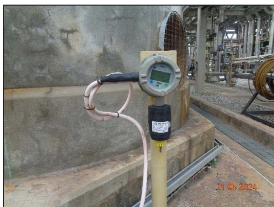
รูปที่ 3.51 Ammonia Gas Detector
